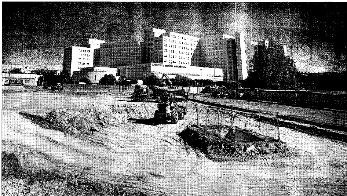
Las máquinas ya han explanado el terreno en el que se construirá el parking de explotación privada en el Hospital General. PILAR CORTÉS
